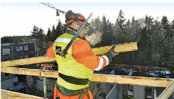
Nolla tapaturmaa -toiminta on parasta vastuullisuutta niin rakennustyömailla kuin muillakin työpaikoilla.
