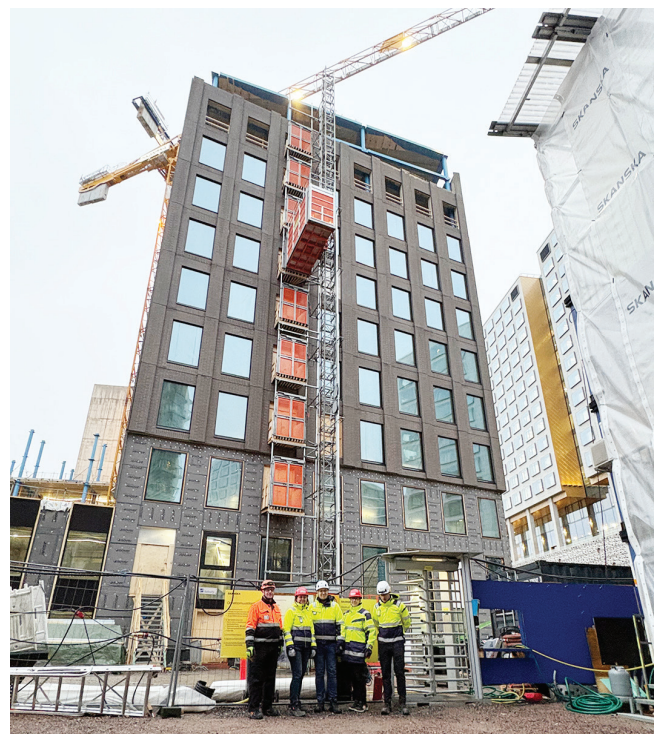
Koulutuspäivien päätteeksi vierailimme Skanskan rakennustyömaalla.
